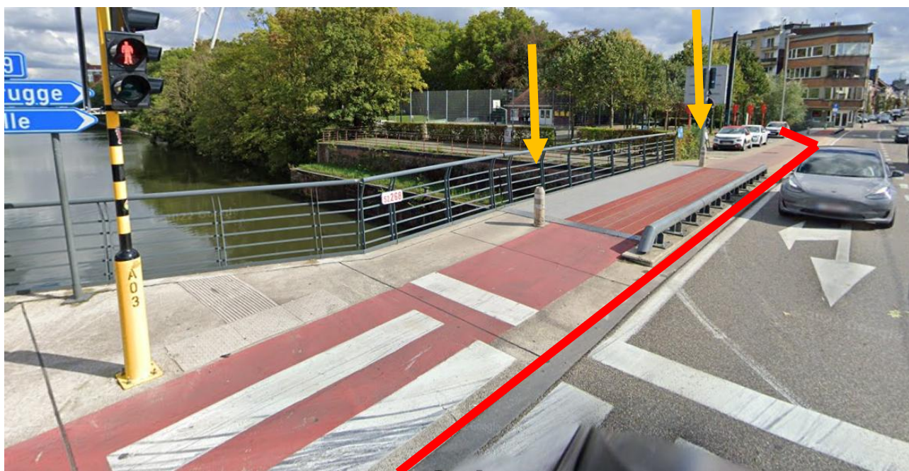
TDW : bij plaatsen parkeerverboden paal verwijderen
