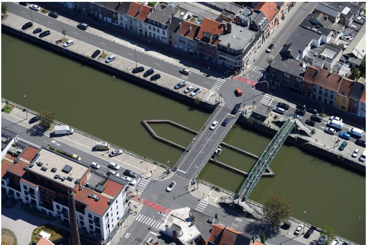
Figuur 2-4 - Kunstwerk 0857 Wondelgemstraatbrug op luchtfoto (bron: De Vlaamse Waterweg)
