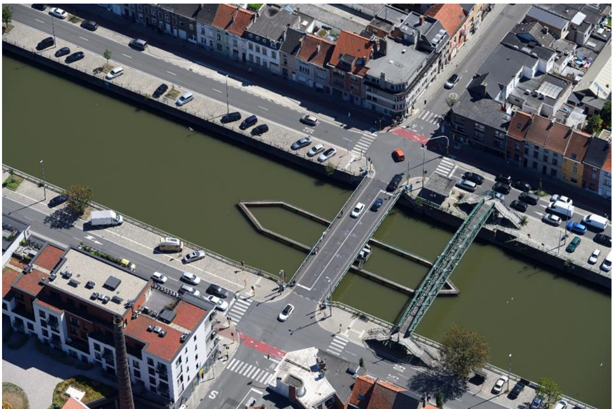
Figuur 1-4 - Kunstwerk 0857 Wondelgemstraatbrug op luchtfoto (bron: De Vlaamse Waterweg)
