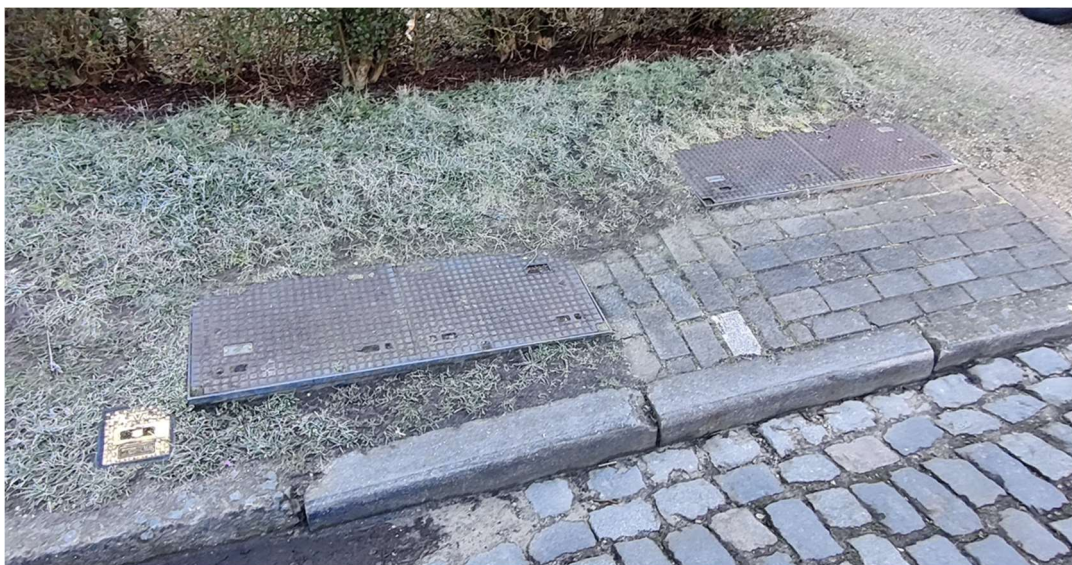
Figuur 4: Foto 2021: inspectieput van het type Proximus.
