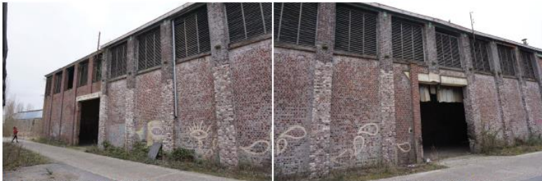
foto 1 westgevel, noordelijk deel
