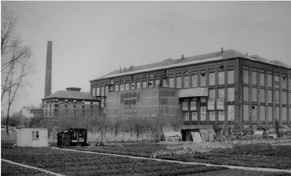
het Manchestergebouw met acclimatisatiekamer en ketelhuis, op de voorgrond volkstuintjes voor de werknemers ca. 1970 © MIAT
