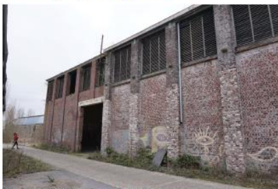
foto 1 westgevel, noordelijk deel
