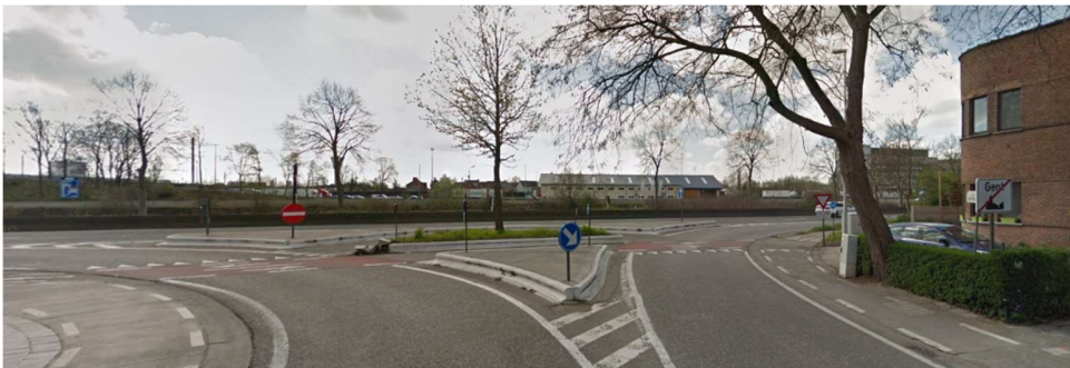
Figuur 2-2 Aansluiting Gestichtstraat/R4, foto richting R4
