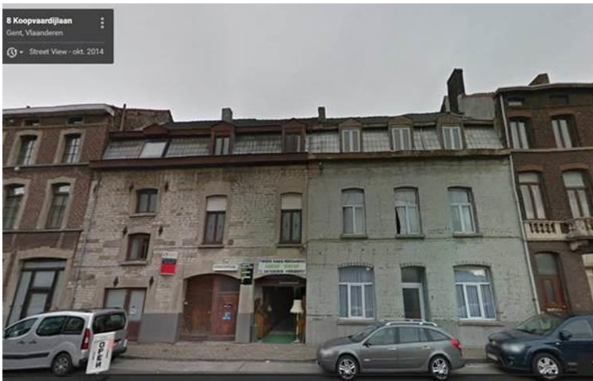
Figuur 111: Pand Koopvaardijlaan 8-10, opgenomen in vastgestelde inventaris
