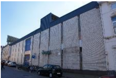
Bestaande voorgevel Wasserij Kunstenaarstraat
