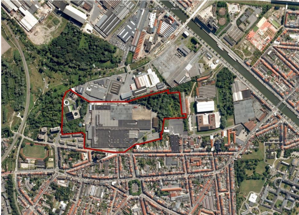
luchtfoto met aanduiding van de door sogent aangekochte UCO-site
