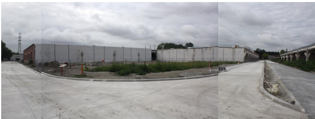
Foto dd. 28 juli 2017, na sloop en met aanleg wegenis rondom
