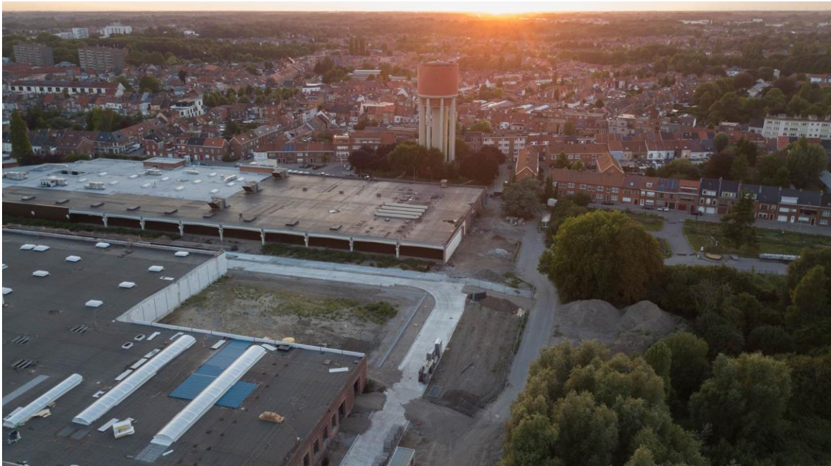
luchtfoto met aanleg nieuwe wegenis, fase 1, en vrijgemaakte zone voor het parkeergebouw © Bart Vermaercke
