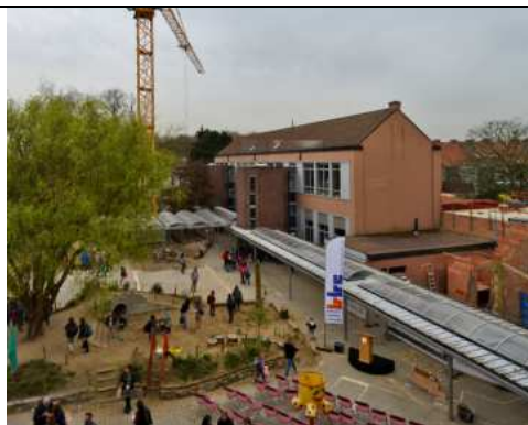
Infrastructuurwerken aan BS De Regenboog. 76 % van de geplande plaatsen is al gerealiseerd.
